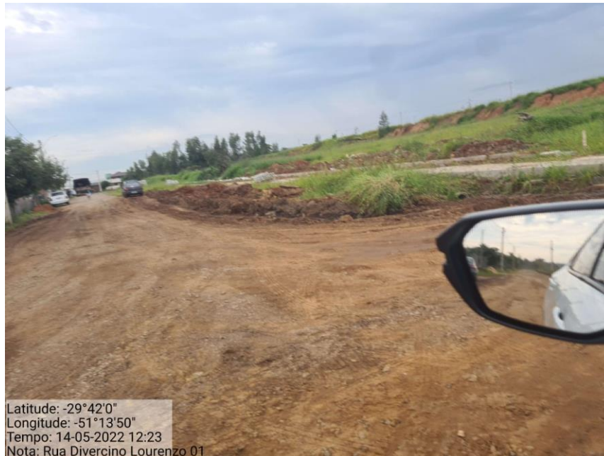
Foto 3: Rua Divercino Lourenço - Final do trecho
