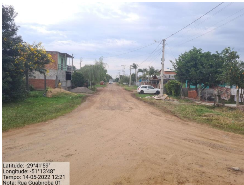
Foto 6: Rua Guabiroba - Final do trecho
